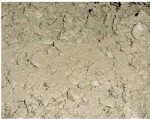
Figura 10 – Exemplo de concreto com falta de argamassa.
