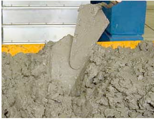
Figura 12 – Exemplo de análise da superfície do concreto
